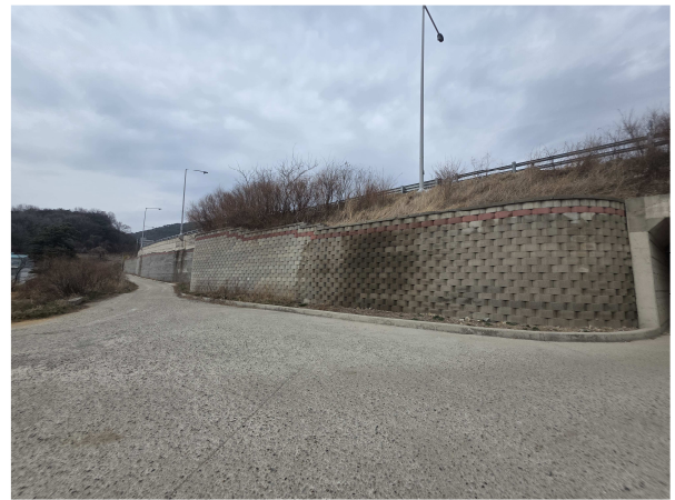
보강토옹벽(STA.2+157.750 ~2+287.500(R)) 종점부 전경
