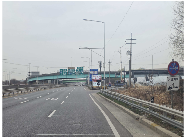
고촌램프D 육교 전경
