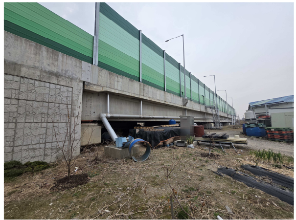
향산2교 RAMP-A교 전경
